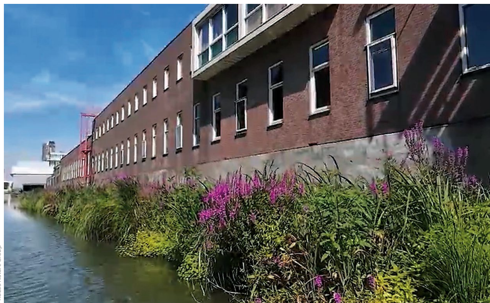
Bild 7: Vegetationsstruktur in einem urbanen Kanalabschnitt in Rotterdam. Die dicht entwickelte, artenreiche Bepflanzung bildet entlang des technisch geprägten Ufers einen naturnahen Übergangsbereich zwischen Gebäude und Gewässer und veranschaulicht die Integration schwimmender Vegetationssysteme in innerstädtische Wasserlagen.
