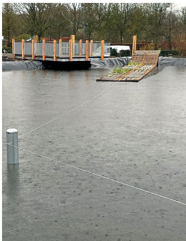
Bild 4: Modulare Vegetationsfläche während der Installation. Links: Verbindung einzelner Schwimmelemente zu einer größeren bepflanzten Einheit. Rechts: Positionierung und temporäre Lagesicherung der modularen Anlage im Gewässer. Flächengröße, Anordnung und Verankerung können an die jeweiligen Standortbedingungen angepasst werden.
