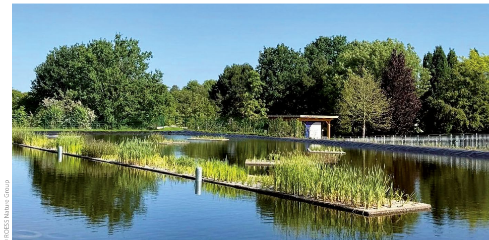
Bild 6: Demonstrationsanlage im Park der Gärten in Bad Zwischenahn. Die unterschiedlich dimensionierten und standortgerecht beplanten Schwimmmodule sind als gestalterische und ökologische Elemente in die öffentliche Park- und Gewässerlandschaft integriert. Die Anlage veranschaulicht zugleich die Entwicklung der Vegetation, die flexible Anordnung der Module und ihre Funktion als sichtbarer Lebensraum auf der Wasseroberfläche.
